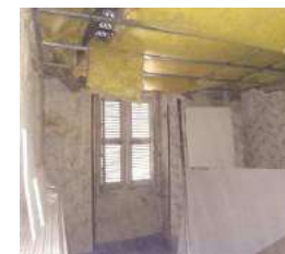
Logement du rez-de-chaussée à rénover
