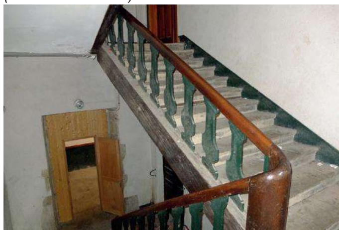
Ancien couvent des visitandines, escalier remanié
