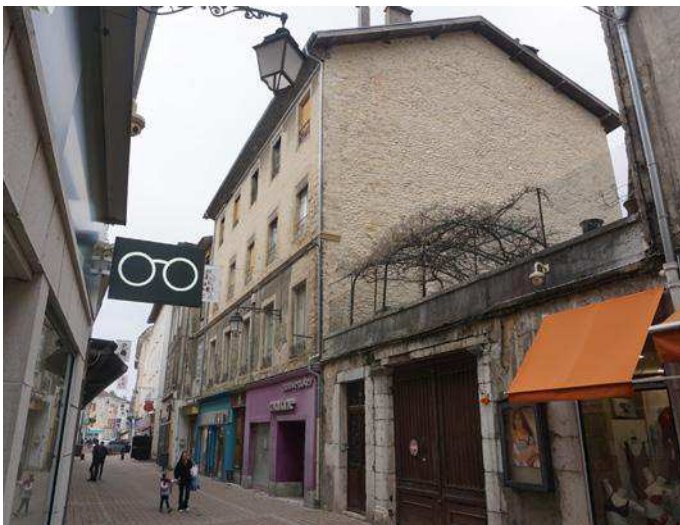
42 Grande Rue - Baies avec garde-corps ouvragés
