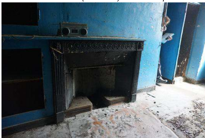
44 Grande Rue - Second niveau
