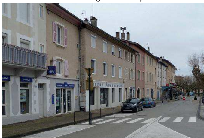
Ensemble d'immeubles de rempart, boulevard du Champ-de-Mars
