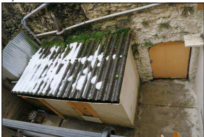
Cour du n°12b permettant l'accès au n°12
