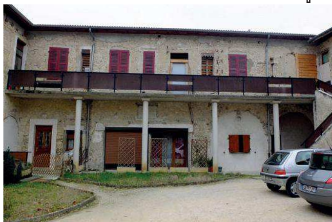
Façade sur cour du couvent des carmes, lecture des arcades bouchées du cloître
