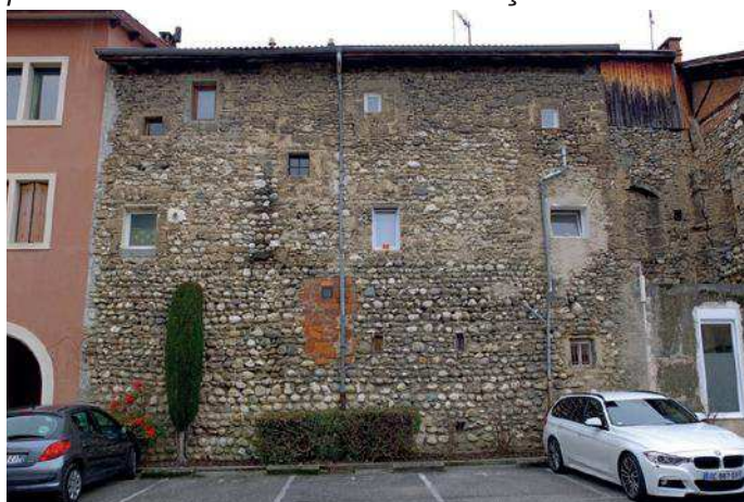
Façade arrière d'un immeuble de rempart, boulevard du Champ-de-Mars, surélévation du rempart
