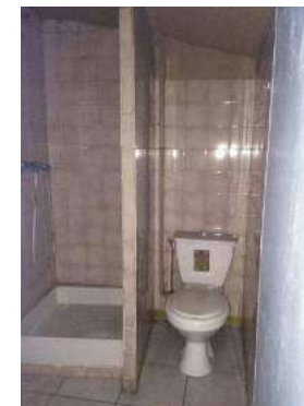
Intérieur du 16B
