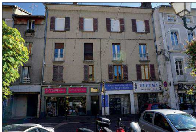
17 Grande Rue - Vue générale
