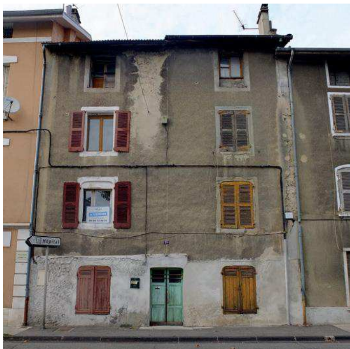
Façade principale sur boulevard Gambetta Lisibilité de la surélévation par différenciation des linteaux, vestiges de décors peints
