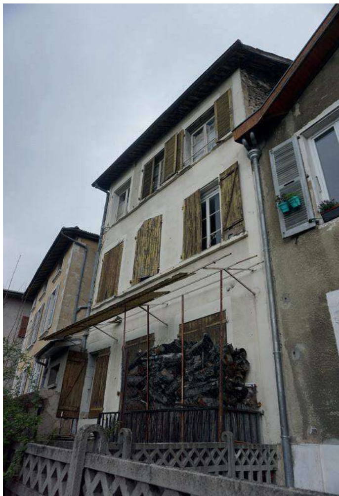
Façade arrière sur la route départementale
