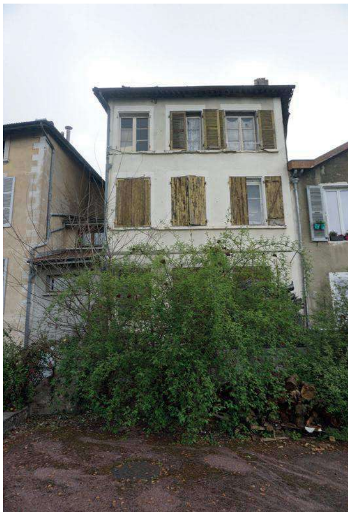
Façade arrière sur la route départementale
