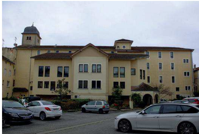
Ancien couvent des ursulines, façade arrière et extension moderne
