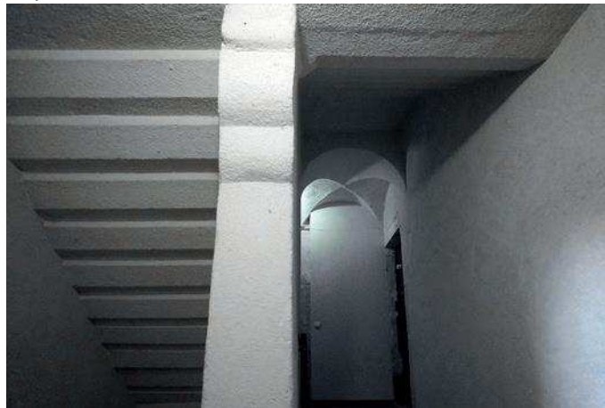
2 passage du Chapeau Rouge - Escalier droit à une volée sur mur d'échiffre, palier voûté d'arête
