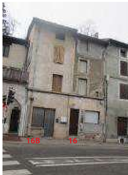
Photo de l'état général extérieur
