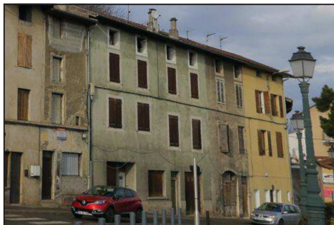
Façade dans l'ensemble bâti
