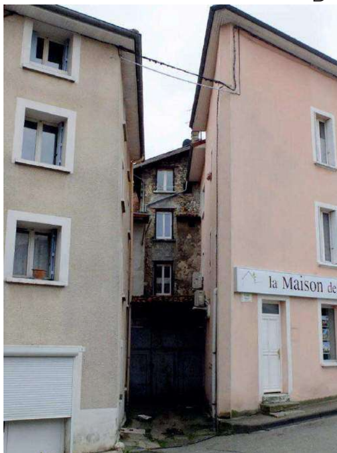
Départ d'ancienne ruelle, place Sully Transformation en accès privé
