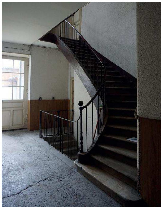
42 Grande Rue - Palier du R+1 Escalier suspendu et accès balcon sur cour
