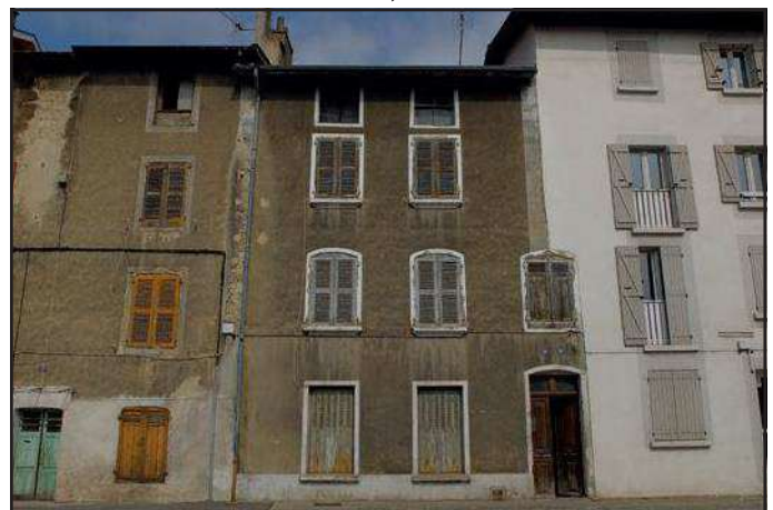
26-28 cours Gambetta, façade sur cours
