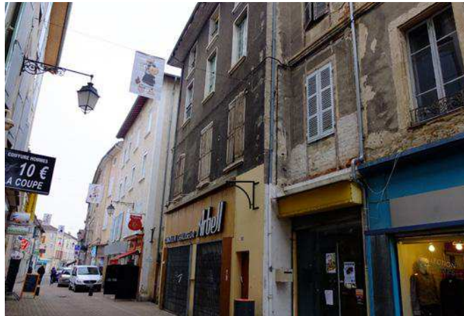
44 Grande Rue - Vue générale
