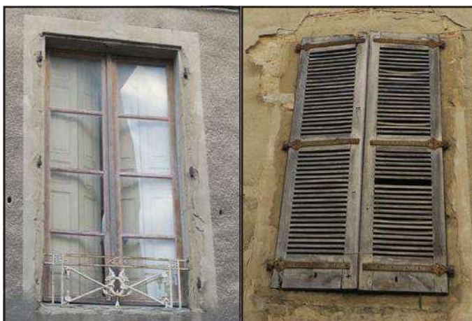
Menuiserie extérieure 1 er étage des 16-18 rue Jean Baillet
