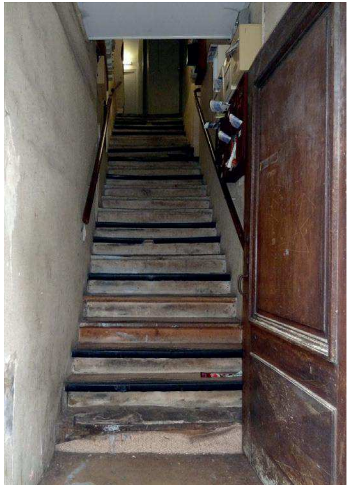
67 Grande Rue - Variante de maison de ville à escalier droit issue de la division du couvent des Carmes
