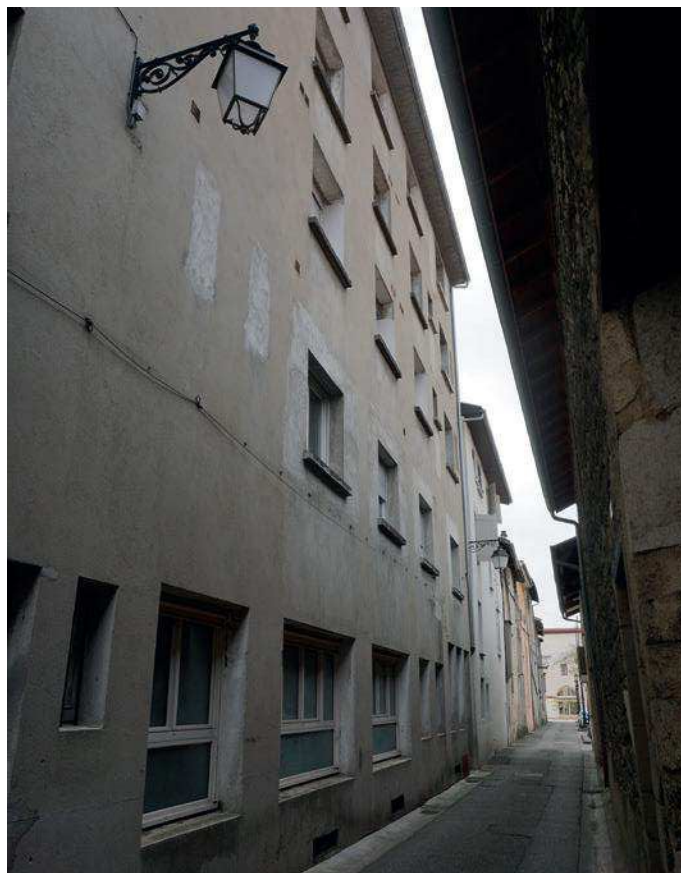
Façade arrière du 22 boulevard Gambetta, le nombre de percements témoigne de la démolition du rempart
