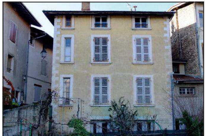
3 passage du Chapeau Rouge - Vue générale
