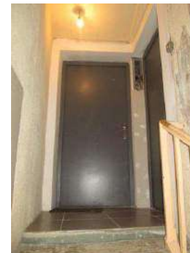
Cage d'escalier du 9, rue de France
