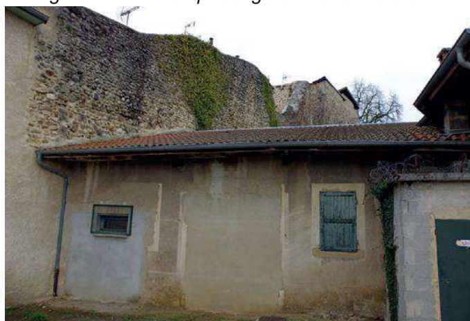
Château - Annexe adossée au rempart, tour de défense à l'arrière
