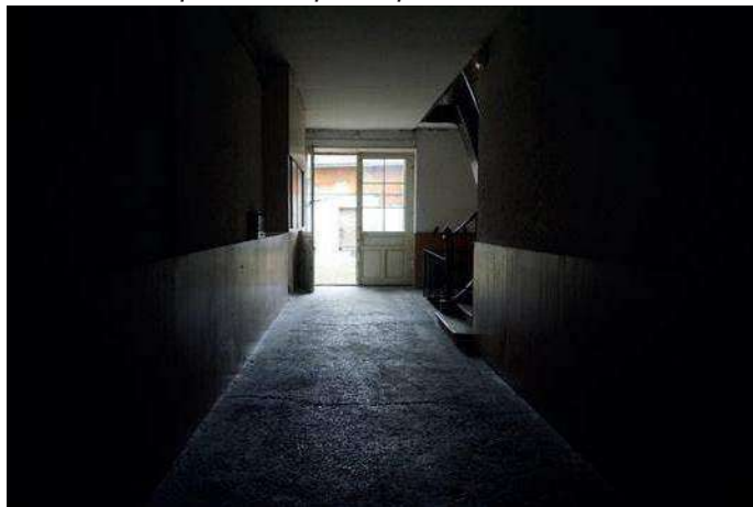
42 Grande Rue - Rez-de-chaussée Vestibule traversant, sol granito
