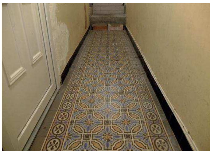
11 rue de France - Carreaux de ciment
