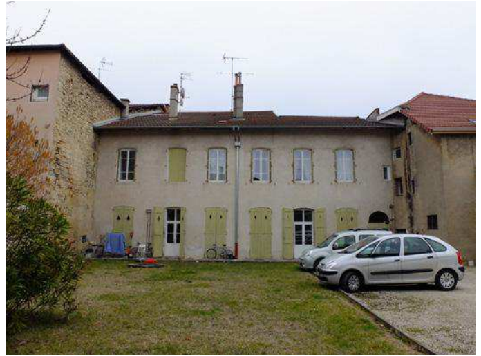
17 place d'Armes - Façade sur cour - Extension du bâtiment initial vers la cour, perte d'un niveau par prolongement du pan de toiture
