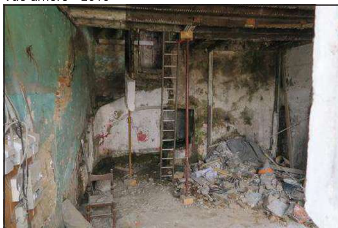
Vue intérieure du rez-de-chaussée - 2019
