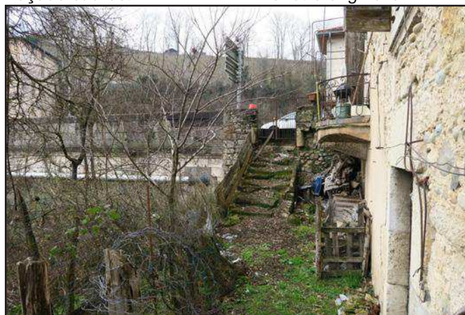
Accès au jardin depuis le trottoir
