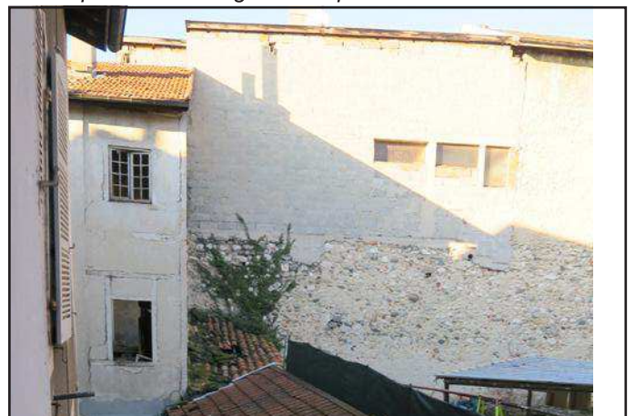
Arrière du bâtiment parcelle 78 : rempart en partie basse
