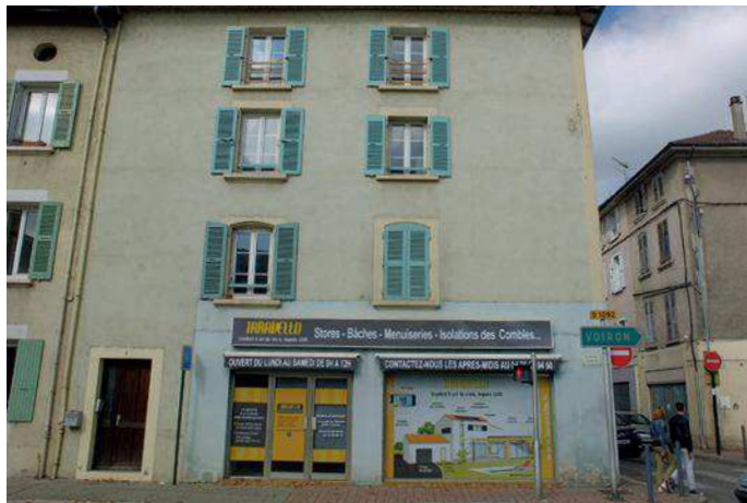
Immeuble de rempart au 2 boulevard Gambetta créé par fusion de deux maisons avec façade conservées
