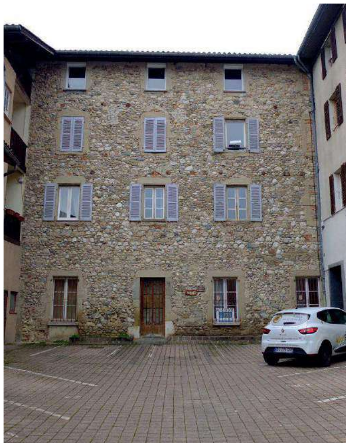
Ancien couvent des visitandines, façade sur cour côté Grande Rue
