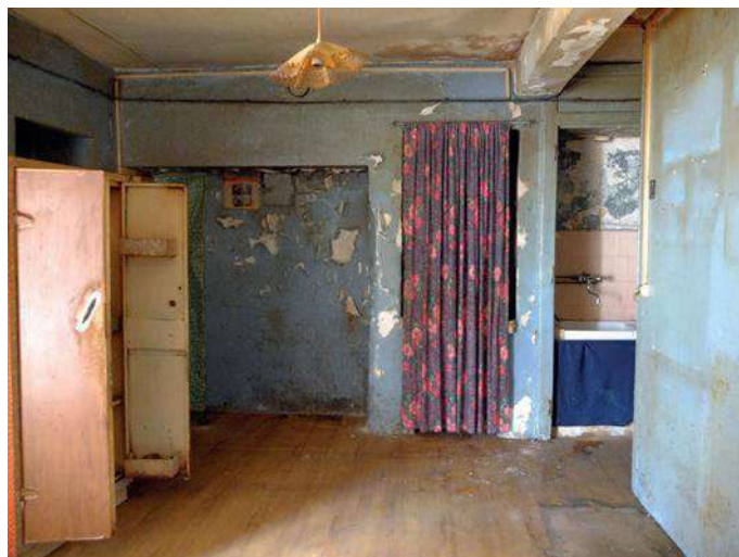
Percement du rempart en fond pour installation de niches et palcards muraux divers au rez-de-chaussée
