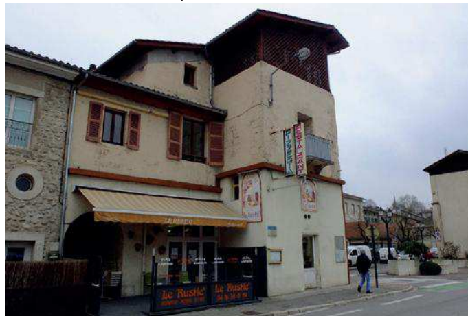
Tour surélevée visible sur le boulevard Gambetta dans l'ensemble de l'ancien couvent des carmes
