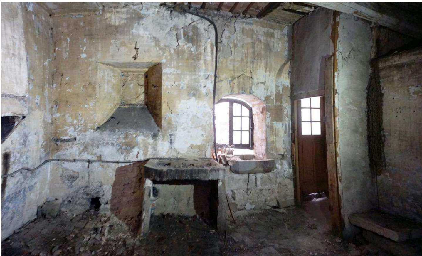
44 Grande Rue - Cuisine au premier niveau
