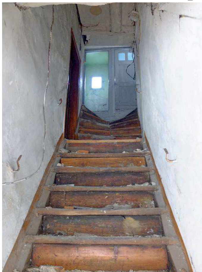
Escalier droit modeste au droit de la porte d'entrée pour desserte d'une maison
