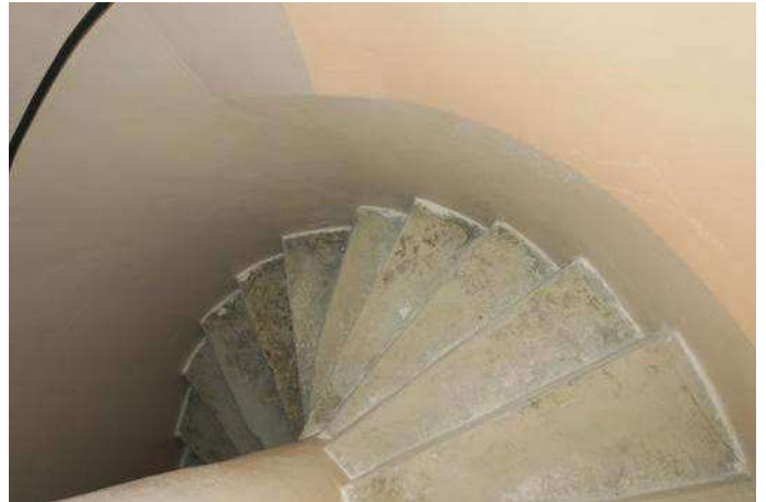
5 rue de la République - Escalier demi-circulaire
