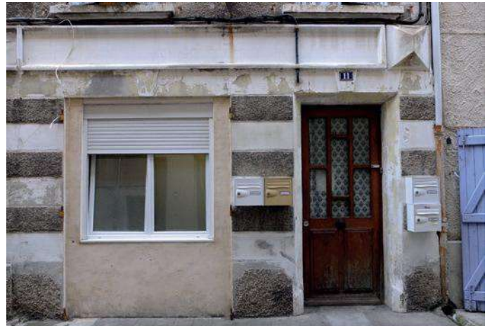
11 rue de France - Rez-de-chaussée remanié XX e s. Réseaux électriques et eaux usées apparents.
