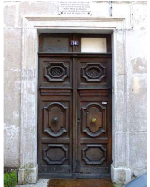
14 rue Jean Baillet - Portail d'entrée monumentale
