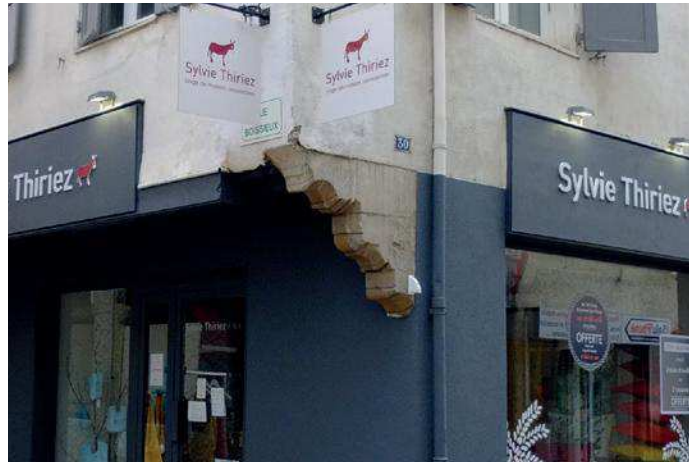
30 Grande Rue - Façade portée sur une poutre bois reposant sur deux consoles de molasse sculptées
