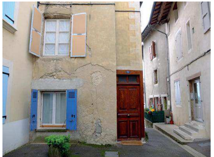
Porte d'entrée et fenêtres.
