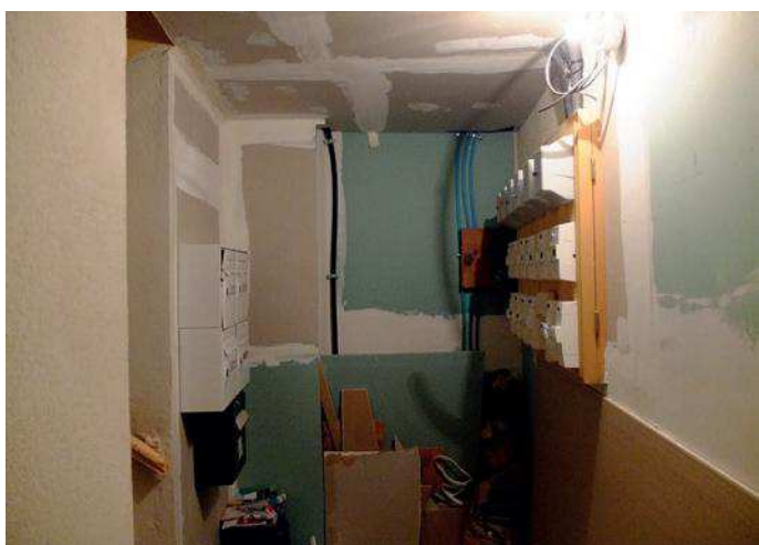
9 rue de France - Encombrement technique du hall 46
