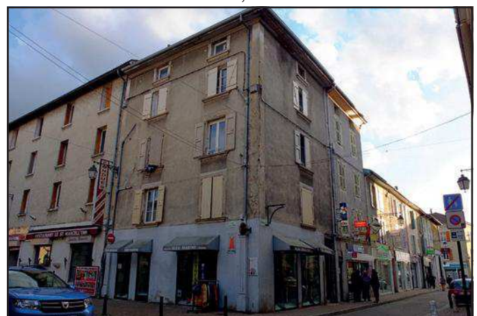
61 Grande Rue - Vue générale
