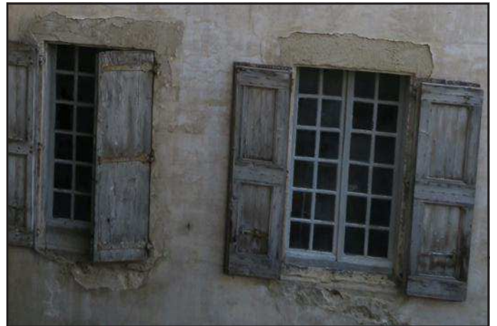
Menuiserie extérieure côté cour
