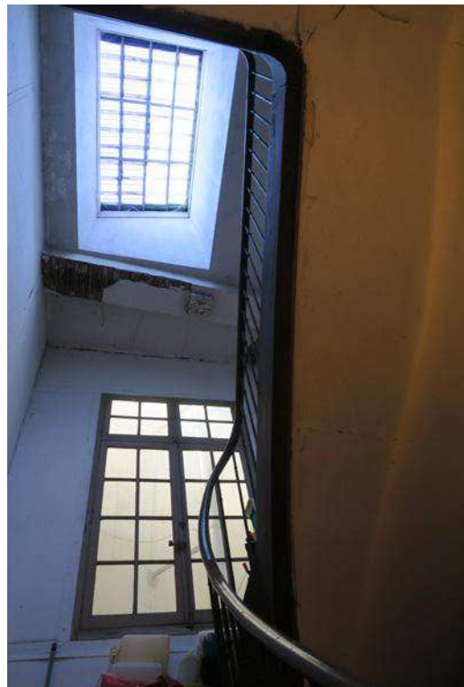
14 rue Jean Baillet - Escalier en bois avec garde corps en fer - Eclairage par courette et zénithale
