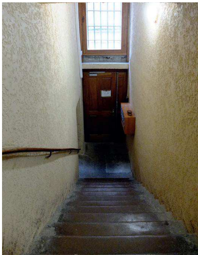
18 rue de France - Escalier droit en pierre, intérieurs modestes
