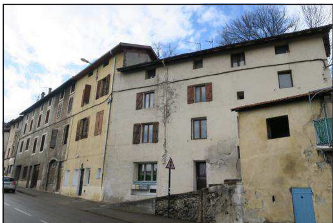
Façade dans l'ensemble bâti
