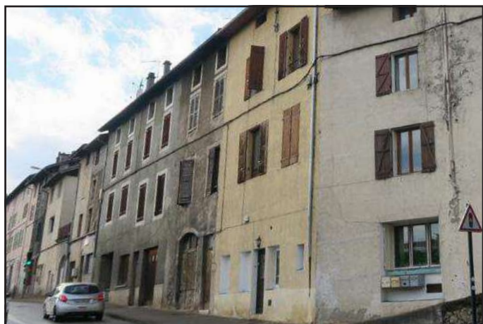
Façade dans l'ensemble bâti
