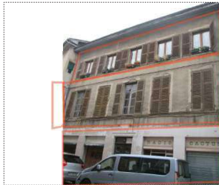
Photo de l'état général extérieur au n°14
