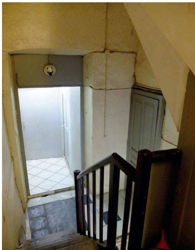
Premier palier, desserte des immeubles des parcelles 297 et 584 172
