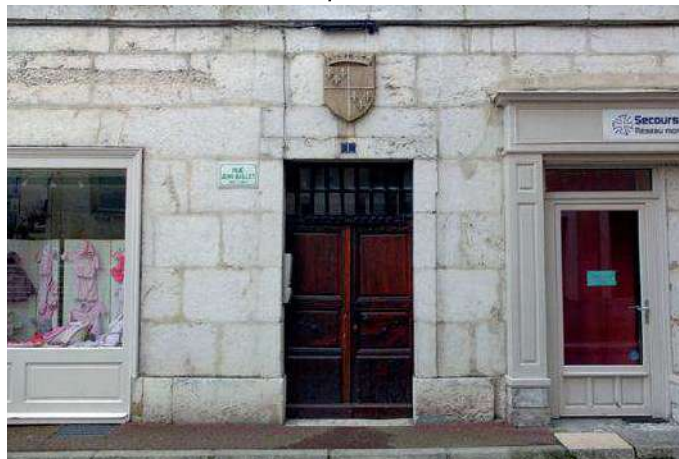
1 rue Jean Baillet - Façade en pierre de taille, encadrement saillant et blason (ancien tribunal)
