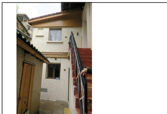
Cour du n°12b permettant l'accès au n°12
