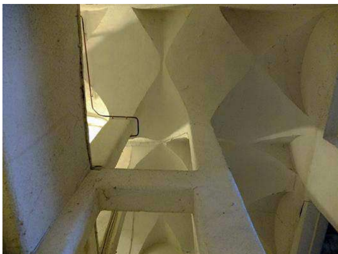
Plafond voûté de l'escalier
