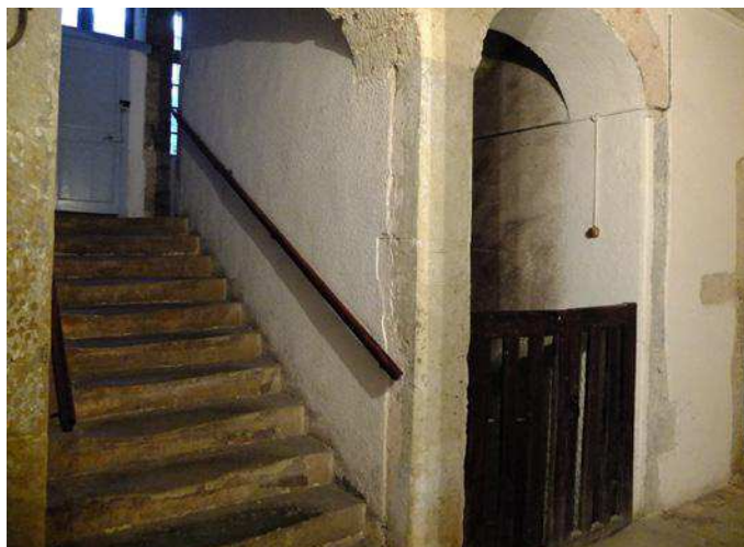
1 passage du Bon Secours - Variante avec escalier droit à 2 volées sur mur d'échiffre, probablement plus ancien
