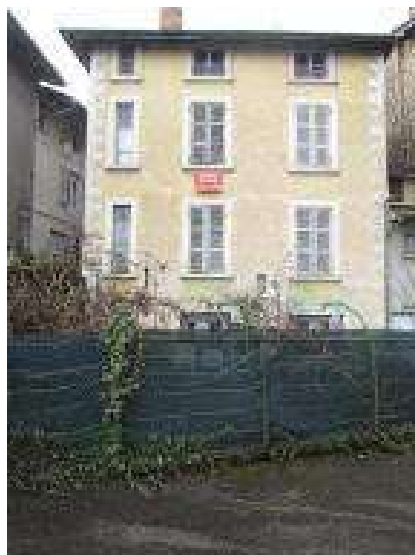
Photo de l'état général extérieur
