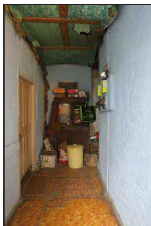
Couloir 2 e étage
