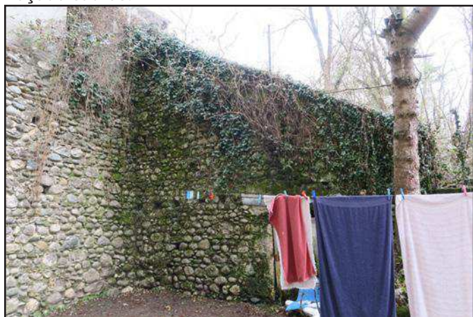
Mur de soutènement dans le jardin
