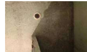
Plafond salle de bain du premier étage
