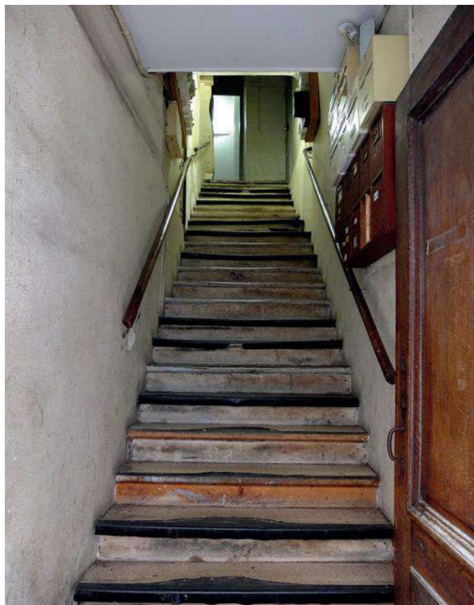
Escalier vers le premier niveau Ensemble peu qualitatif
