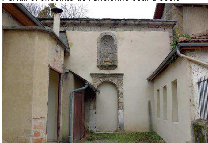
Château - Edifice en fond à l'est Vestiges d'un ancien passage et niche murale
