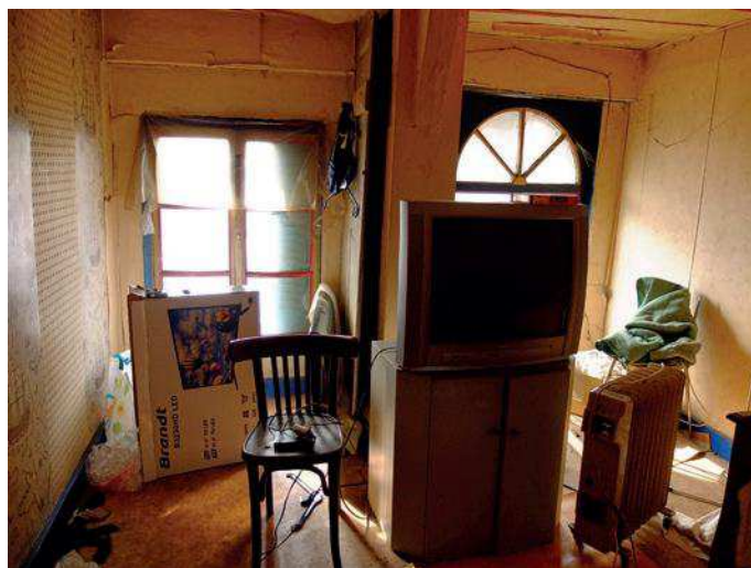
Pièce donnant sur le balcon, la fenêtre en plein-cintre diffère des autres ouvertures de la façade
