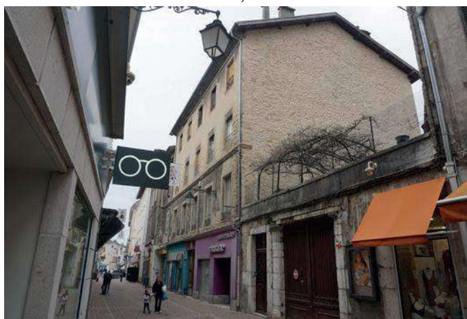
42 Grande Rue - Vue générale
