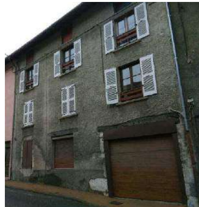
Photo de l'état général extérieur
