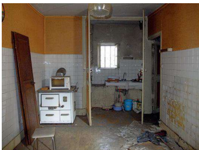
Rez-de-chaussée, percement d'une cuisine dans l'épaisseur du rempart
