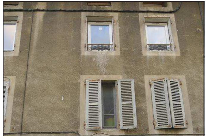
Volets persiennés et garde-corps ferronnés
