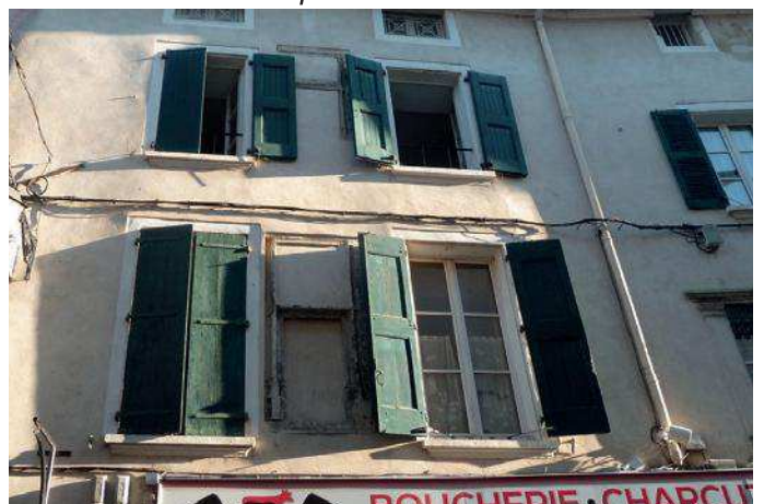
47 Grande Rue - Façade du XV e siècle conservée, modification des percements au XIX e siècle
