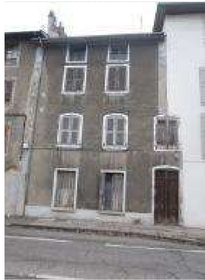
Photo de l'état général extérieur
