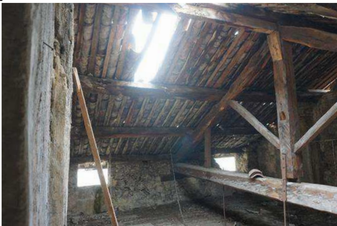
44 Grande Rue - Charpente et comble Trous en toiture, infiltrations massives, péril imminent
