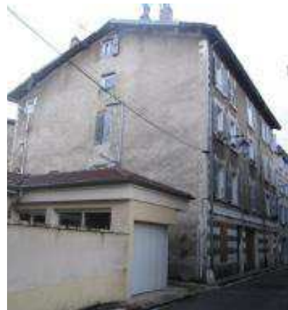
Photo de l'état général extérieur
