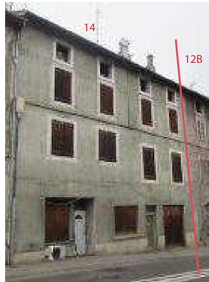
Photo de l'état général extérieur
