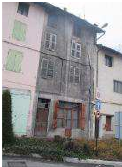
Photo de l'état général extérieur
