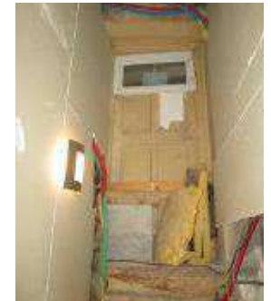
Cage d'escalier du 11, rue de France
