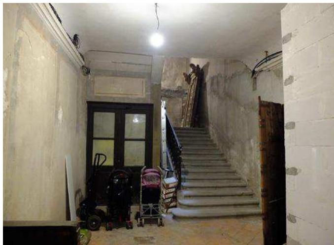
40 Grande Rue - Escalier droit suspendu à 2 volées
