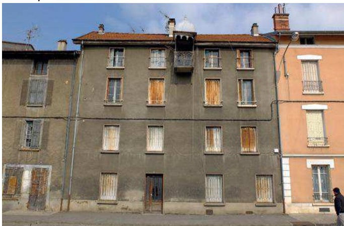
Façade avant entièrement reconstruite d'un immeuble de rempart, 34 boulevard du Gambetta
