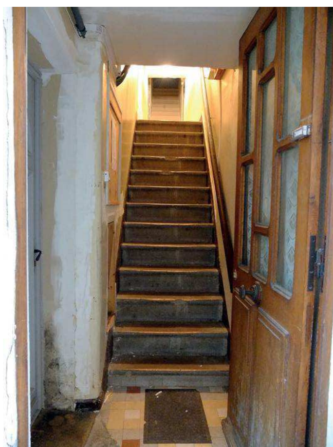
11 rue de France - Escalier à deux volées droites.
