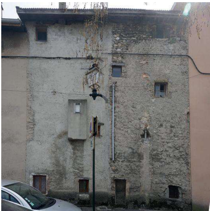
Façade arrière du 30 boulevard Gambetta. Le rez-de-chaussée a été percé de cuisines dotées de petites baies. Un WC a été ajouté en hors œuvre au premier niveau. L'ensemble demeure peu percé.
