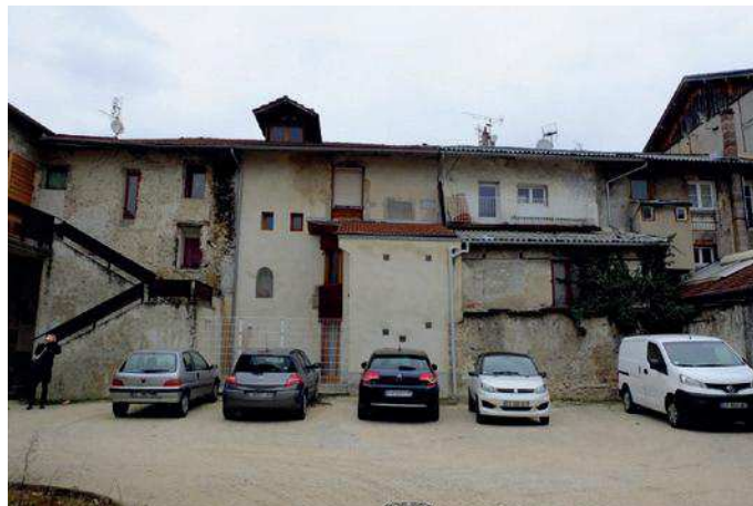
Façade sur cour du couvent des carmes, construction de nombreux édicules en façade
