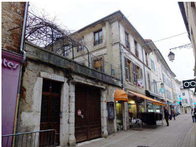
40 Grande Rue - Vue depuis la rue, accès par un porche ajouté au XIX e siècle en remplacement probable d'une grille
