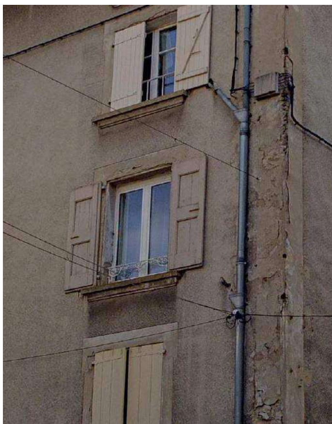
Chaînage d'angle peint sur enduit chaux, lambrequin fonte
