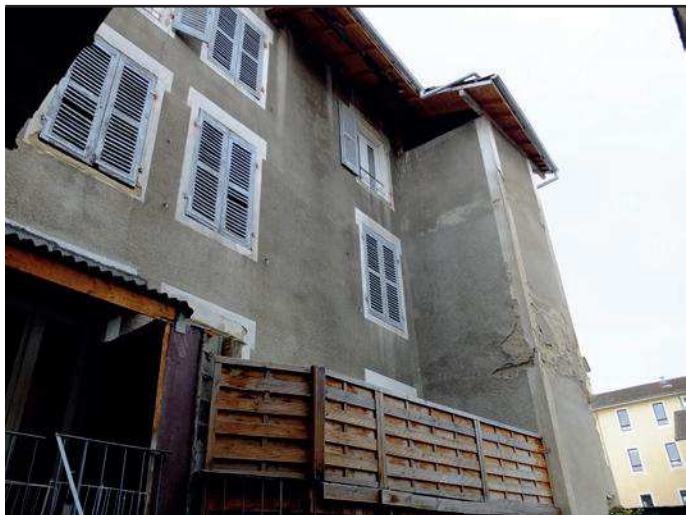
9 rue de France - Elévation sur cour
