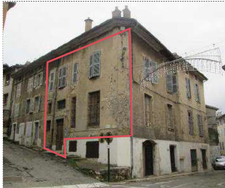
Photo de l'état général extérieur
