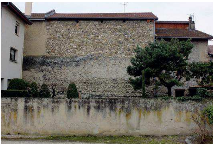
Portion de mur à l'arrière du 17 place d'Armes relativement homogène malgré une surélévation
