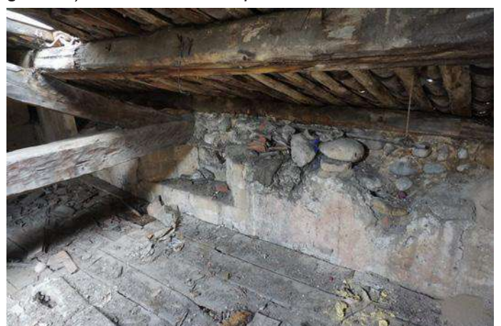
44 Grande Rue - Charpente et comble Anciennes ouvertures, traces d'abaissement du toit
