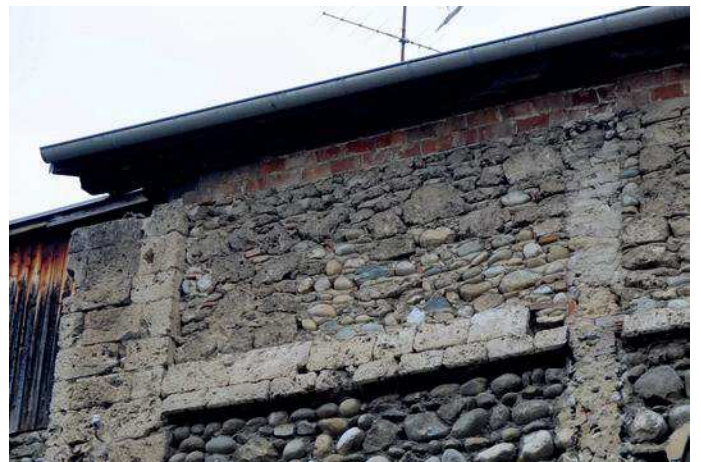
Vestiges d'un larmier en tuf en partie haute du mur d'enceinte témoignant d'un couverture de la courtine
