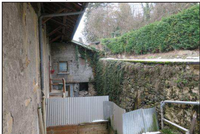
Partie arrière (bas), ancienne ruelle
