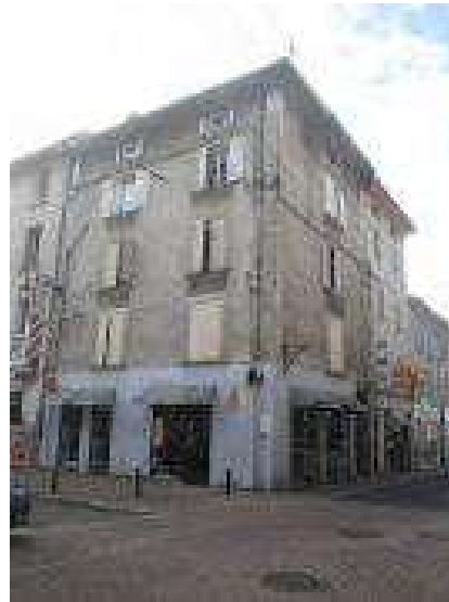
Photo de l'état général extérieur
