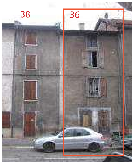
Photo de l'état général extérieur
