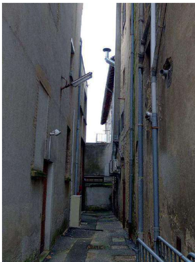
Départ d'ancienne ruelle, avenue du Collège Desserte de l'arrière de la mairie (Biocoop)
