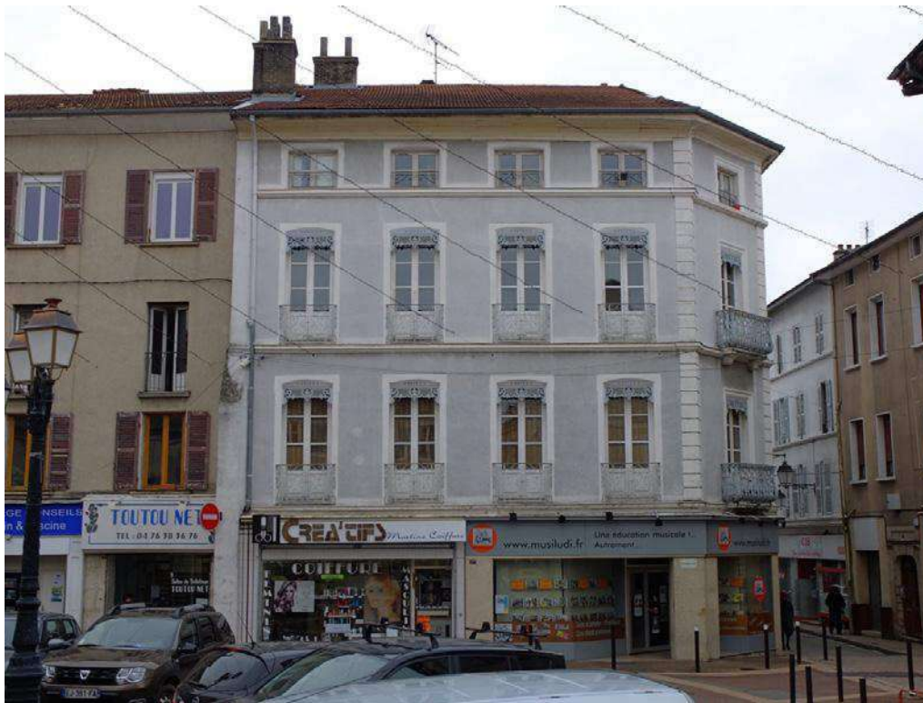
1 rue de Beauvoir - Immeuble à escalier suspendu à quart tournant
