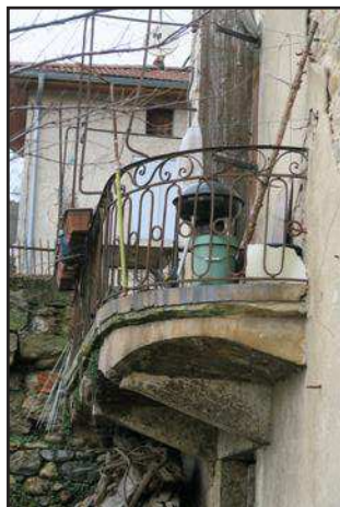
Balcon avec ferronnerie
