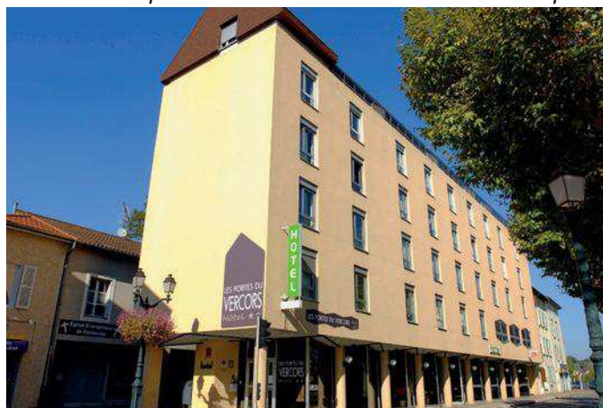
Façade avant du 8 boulevard Gambetta, édifice reconstruit après démolition de maisons de rempart
