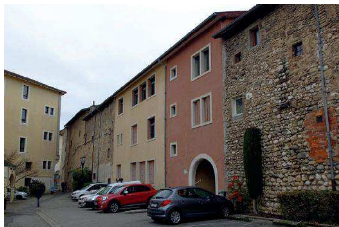
Façades arrières reconstruites sur la square Emile Bouy
