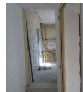
Travaux en cours au N°10
