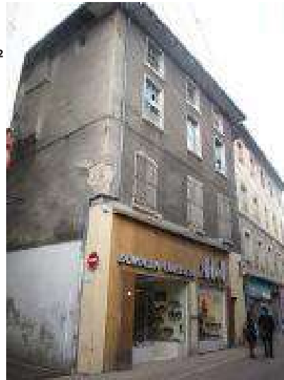
Photo de l'état général extérieur
