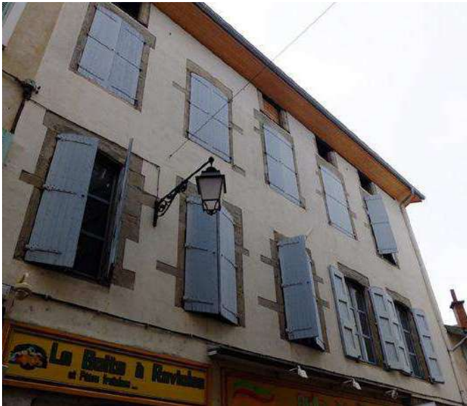
57 Grande Rue - Baies à linteaux délardés
