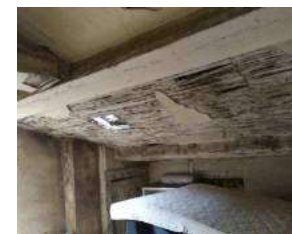
Greniers au 3ème étage du n°14
