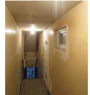
Cage d'escalier du 11, rue de France
