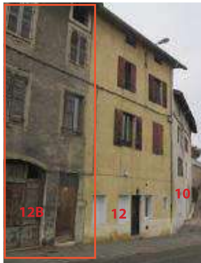
Photo de l'état général extérieur
