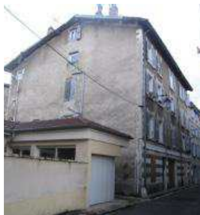
Photo de l'état général extérieur
