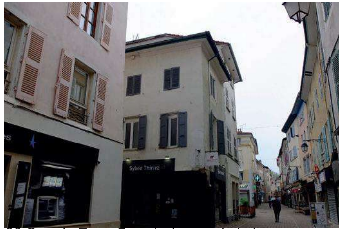
30 Grande Rue - Façade à pans de bois
