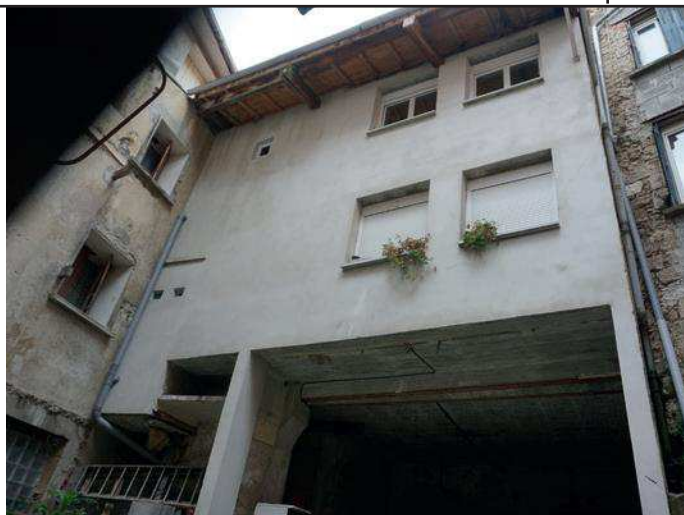
11 rue de France - Elévation sur cour
