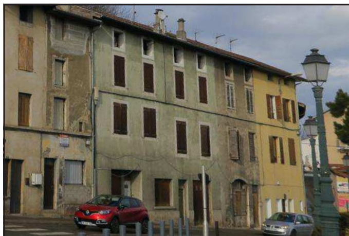
Façade dans l'ensemble bâti
