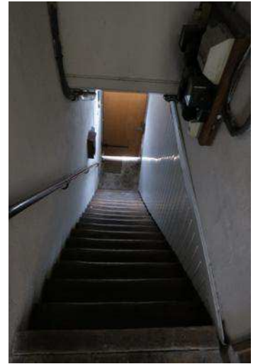
12-12b rue du Faubourg Vinay - Escalier droit
