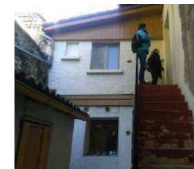
Façade sur cour du N°12, 1e étage et accès au 2e étage par l'escalier
