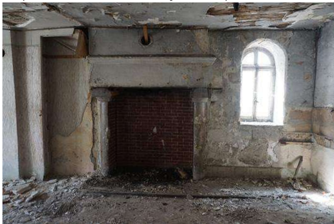
44 Grande Rue - Second niveau
