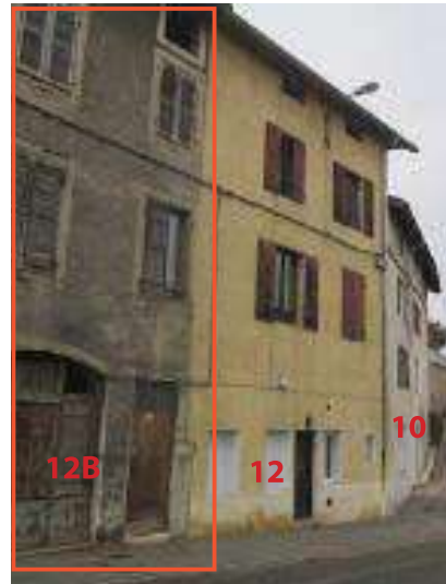
Photo de l'état général extérieur
